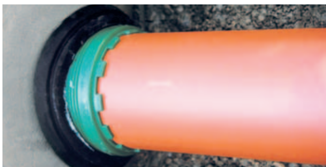
Introducerea tubului în coroana de înșurubat AWADOCK până la opritor
