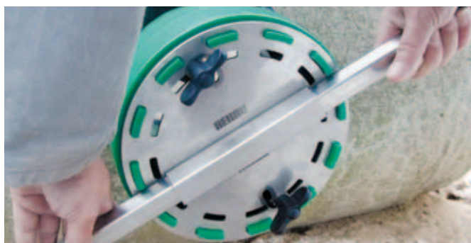
Înșurubarea coroanei de înșurubat AWADOCK în garnitura de racordare
