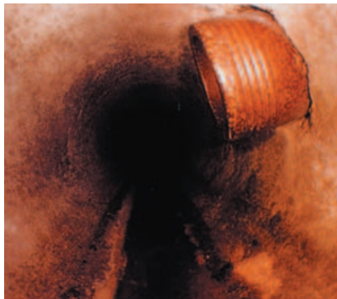
Conductă laterală defectuoasă - ștuț de racordare proiectat în interiorul conductei
