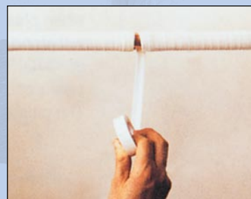
Când îmbinarea este gata și s-a răcit, se readuce plasticul în poziția inițială și se acoperă tăietura cu bandă din plastic impermeabil
