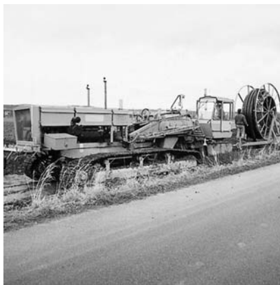
Montaj prin săpare și îngropare directă cu plugul
